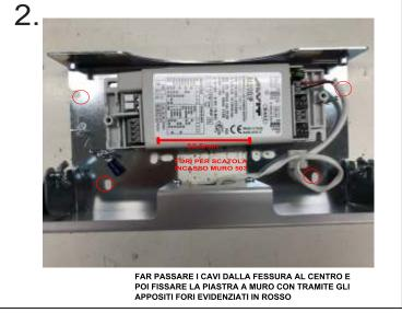
MAKE THE CABLES FROM THE CRUSH TO THE CENTER AND THEN FIX THE WALL-MOUNTED PLATE THROUGH THE SPECIAL HOLES SHOWN IN RED
